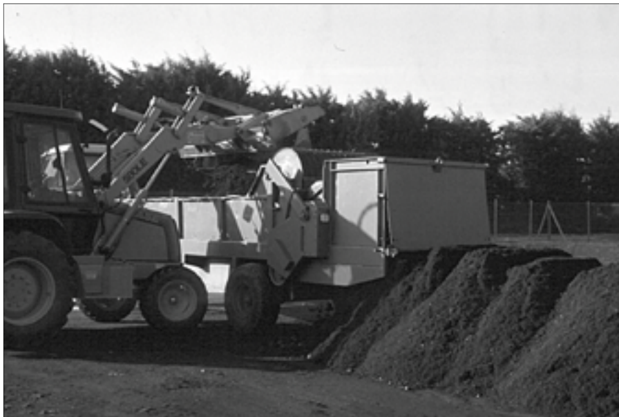
Mise en place d'un andain après mélange et broyage
